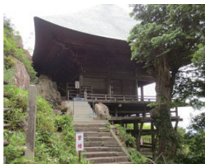
西光院本堂の様子
