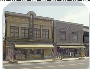
左より「十七屋履物店」と「久松商店」。十七屋はモルタル塗りです。左官細工に凝ったもの、久松商店はモルタル塗りの上に銅板を葺いたもの。
