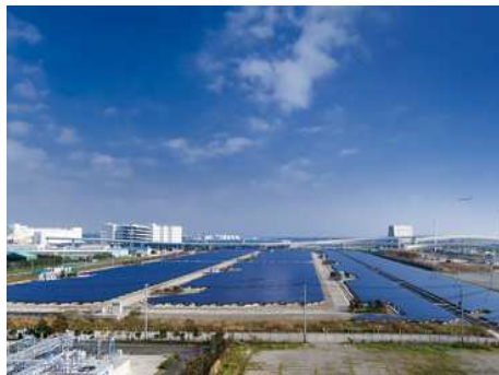
最大出力 7000kW のメガソーラー 「浮島太陽光発電所」
