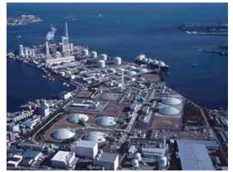
最初に LNG (天然ガス) を導入した 「東京ガス根岸工場」
