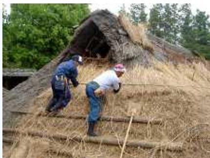
[写真2] 茅葺屋根の葺き替え作業（常陸風土記の丘）
