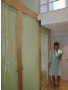
壁にはFRP グレーチング
