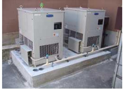
通常の発電機は、手でスイッチを入れることによって発電を始めます。ところがこのLPG発電機は停電と同時にエンジンが自動運転し、40秒後には発電を開始します。またその逆に、電力復旧後は自動的に発電を停止する仕組みです。LPGガスは、他の燃料を寄せ付けないほどクリーンなエネルギーなので、エンジンオイルの交換は半年に1度と手間いらず。またメンテナンスも充実しています。
